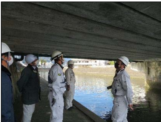
管内橋梁視察
