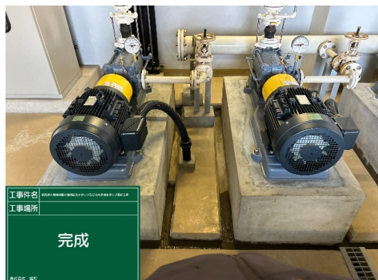
朝見浄水場機械脱水機棟圧力水ポンプ及びろ布洗浄水ポンプ更新工事
