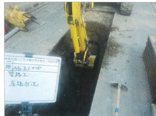
東荘園八丁目4番外污水管きょ布設工事
